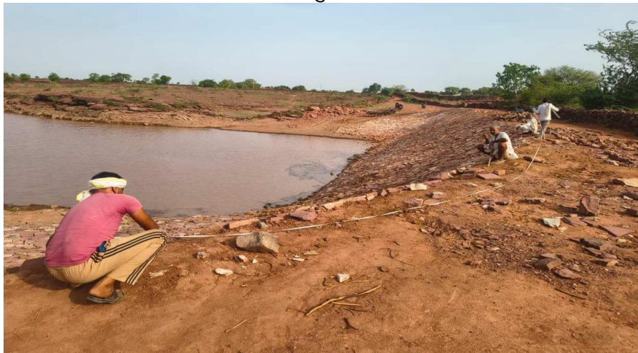
चित्र 8.2: जंजारीपुरा गाँव में पोखर निर्माण कार्य का नाप लेते ग्रामीण
