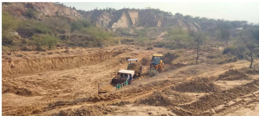
चित्र 8.10: गांव में पोखर निर्माण कार्य प्रगति पर
